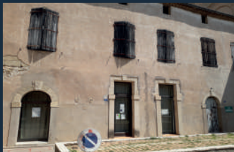
MAISON DES SERVICES AU PUBLIC
